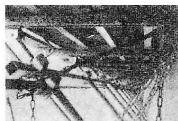
⑥バックリングを防ぐため、根がらみと要所をチェーン、ターンバックルで引っ張りを入れてください。
