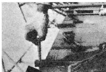
②孔にナットをセットした吊ボルトを差し込んでください。
