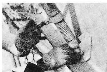
④下部の端部はH鋼に密着させます。高さの微調節はハンドルで行ってください。
